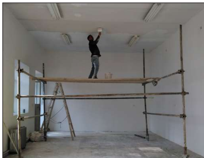
رنگ آمیزی دیوارهای داخلی
