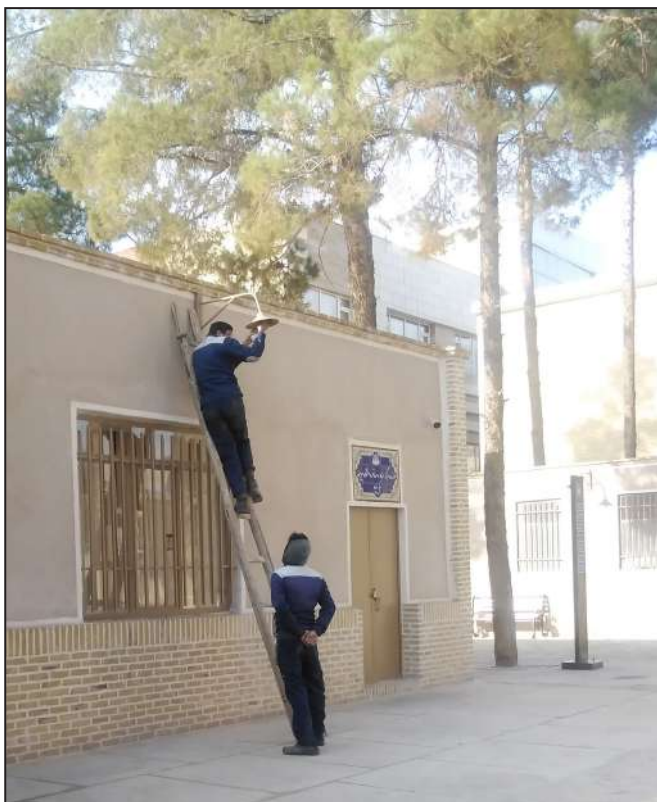
نصب چراغ های محوطه
