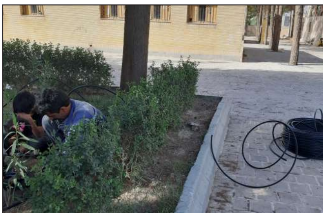
نصب سیستم آبیاری قطره ای
