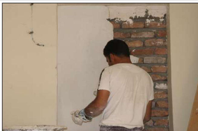
گچکاری دیوارها و ترمیم کف انبار
