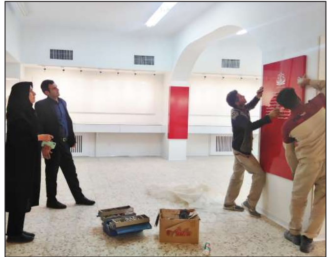
نصب تابلوی ورودی موزه آموزش
